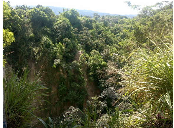
Fotografía tomada durante diligencia de inspección.
