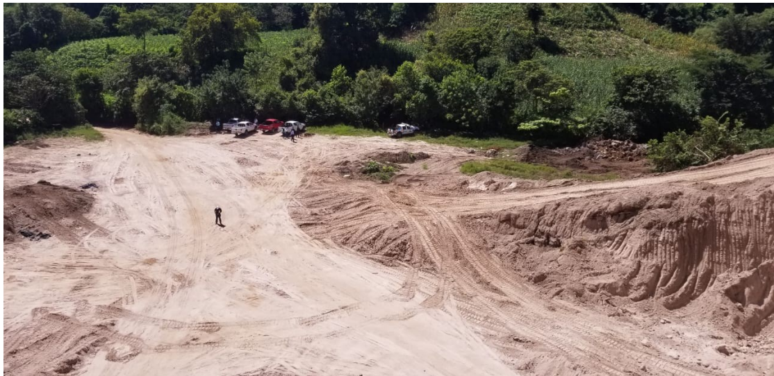
Fotografía tomada durante diligencia de inspección.
