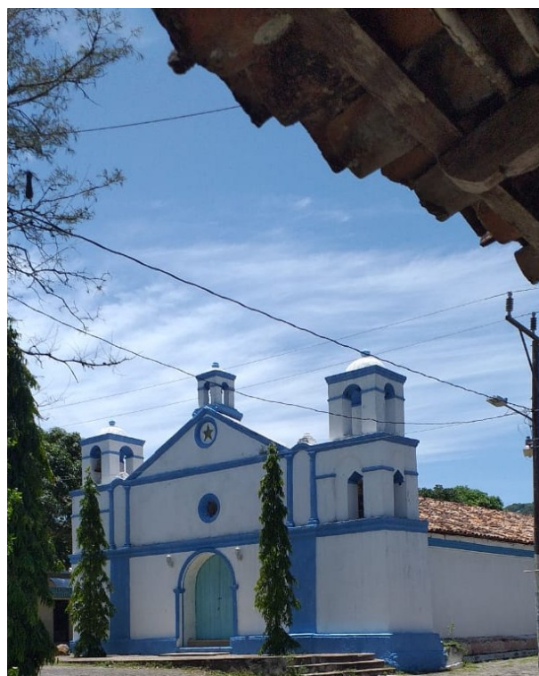
Fotografía tomada durante diligencia de inspección.
